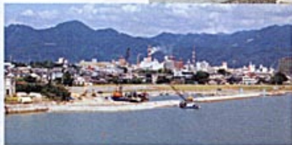
現在の工事風景
