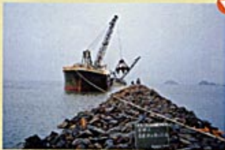
昭和62年当時の八代港。工事着工前。
