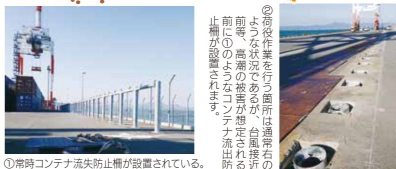
①常時コンテナ流失防止柵が設置されている。
